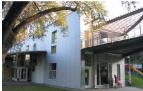
Die sanierte Fassade des Kindergartens
