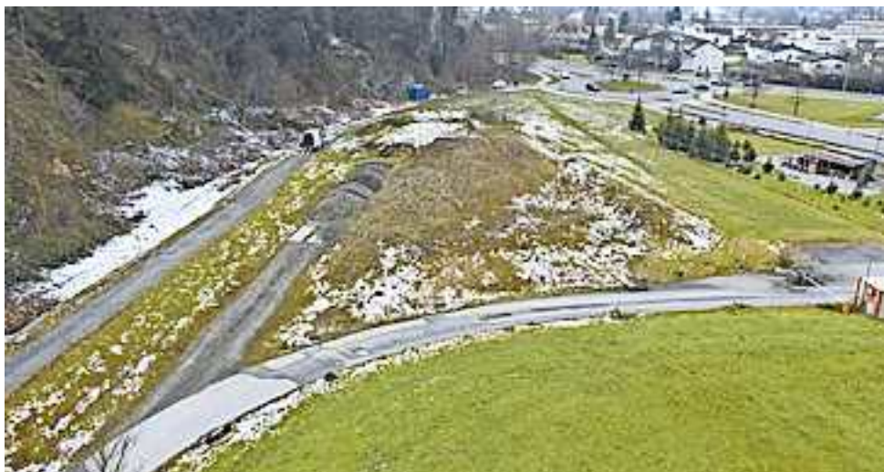
Im Bereich Kobel soll das Altstoffsammelzentrum Mittleres Rheintal entstehen.
