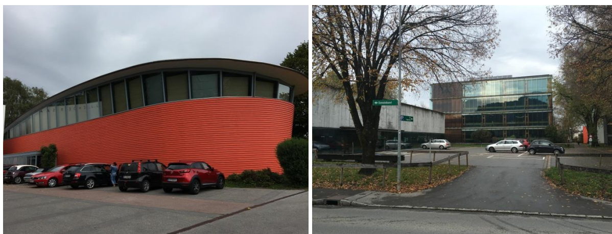
Abbildung 2-3: J.J. Ender Saal und ÖKO Mittelschule, beide von Baumschlagler-Eberle Architekten
